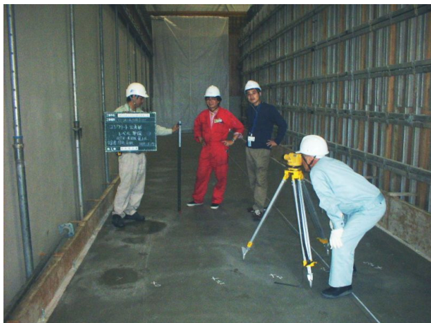
写真5. 施工後床レベル確認時の様子
