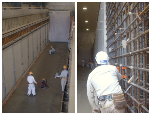
写真3,4. コンクリート天端押さえ時の風景
