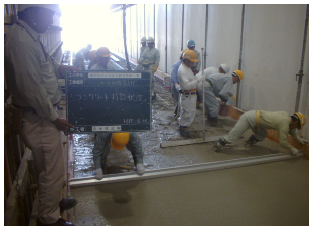
写真2. 定規を使った土間ならしの様子
