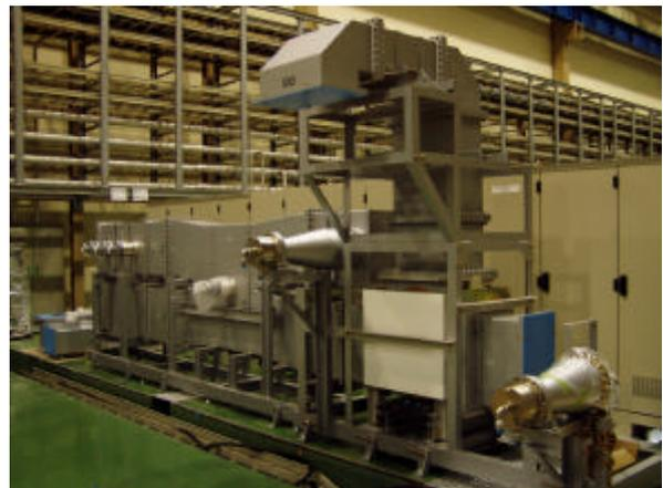
写真1 設置工事中の立体回路(1ユニット)
