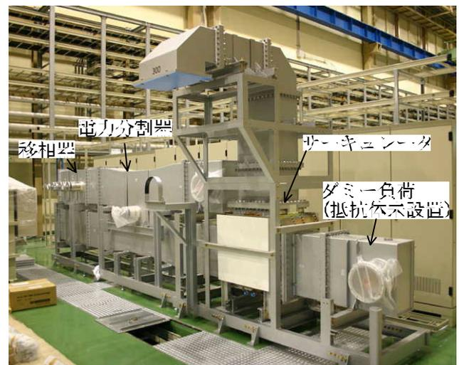
図3：立体回路(WR-2300)の設置状況
