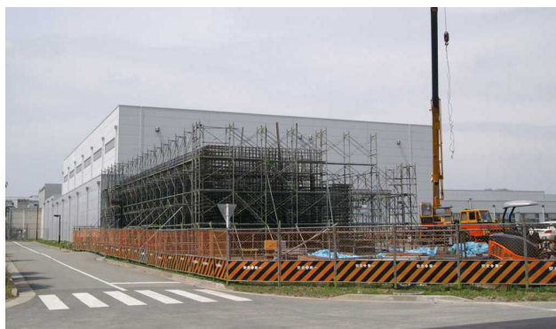
図2 組立調整棟、SCSS試験加速器建設(2005/05)
