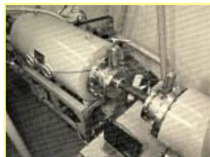
図3 コッククロフト・ウォルトン電子加速器（写真）
