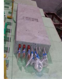
コンクリート打設後(P6)
