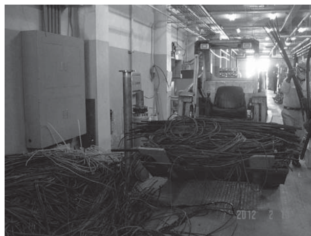
Fig. 3 床下やピットから出て来た無用なケーブル。これはほんの一部にすぎない。
