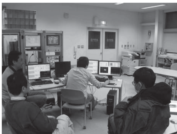
図 15 制御室の様子
