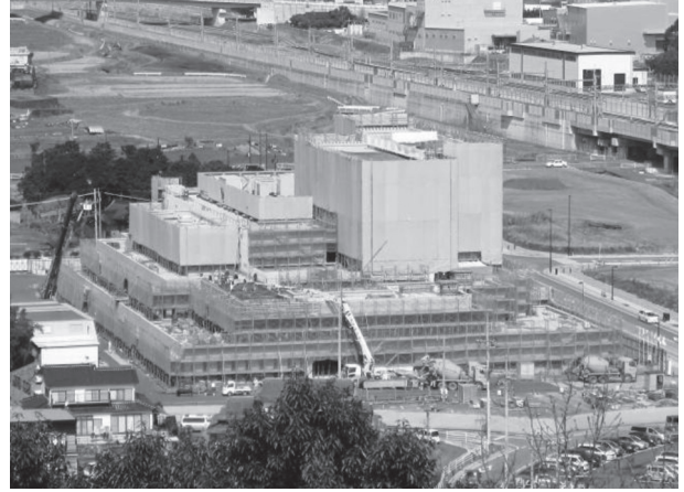
図10 2012年2月中旬の建築現場の状態で、最後のコンクリート打ちの時。建設現場の右上の線路が新幹線の新鳥栖駅から伸びている線路。
