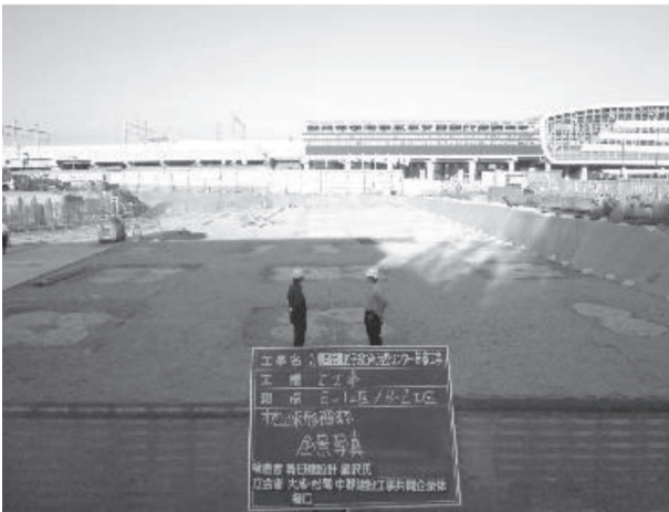
図9 地盤改良法の写真。深層混合処理工法による地盤改良を行ったところが円形状に白っぽくなっている。2011年4月初めの建設現場風景。右奥が新鳥栖駅。
