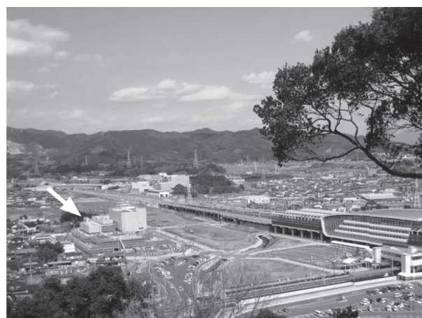
図2 新幹線の新鳥栖駅（右端）に対する建設中の重粒子線治療施設の位置（矢印が建設中の施設）.
