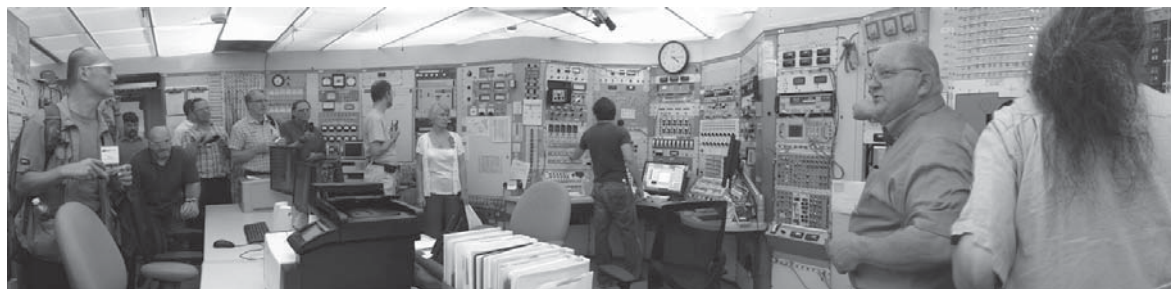
図3 見学で訪れたLBNLの88インチサイクロトロン制御室、加速粒子やエネルギーを変更する場合には、10分程度でノートに記録されているパラメータを1つずつ設定し、微調していく。1960年代から変わらない。
