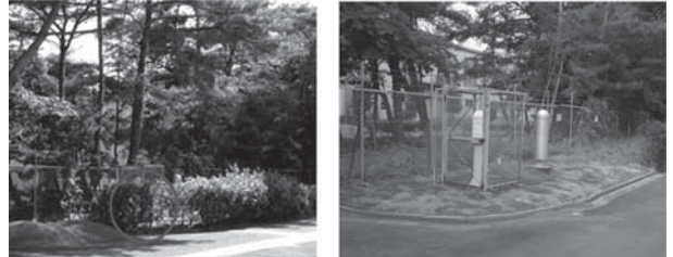
図3 モニタリングポストの除染（左：前0.6 \mu\text{Sv/hr} 、右：0.3 \mu\text{Sv/hr} ）
