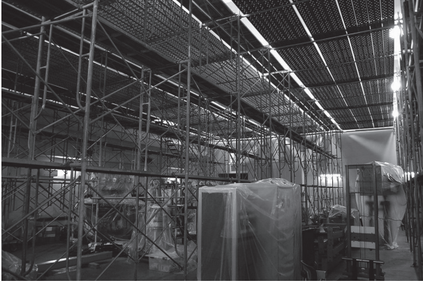
図 23 第2測定室の現況（2012年2月）。全ビームラインが撤去されて、室内の震災復旧工事を実施中である。
