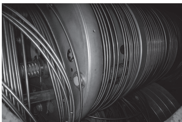
図 17 4 階の加速器マンホールから撮影された崩落した加速管コラム.
