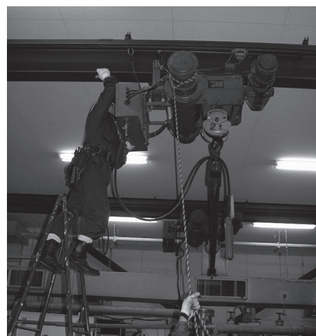
図 20 9 階の 2 トンクレーンの修理作業.
