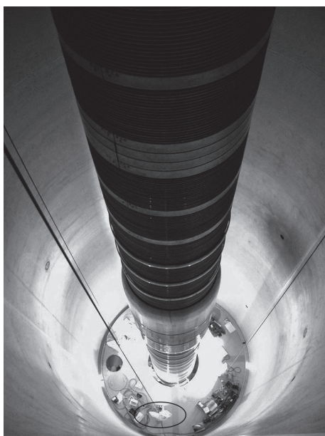
図3 震災前の加速器タンク内部の写真。丸で囲った部分にゴンドラ上の作業員が写っている。
