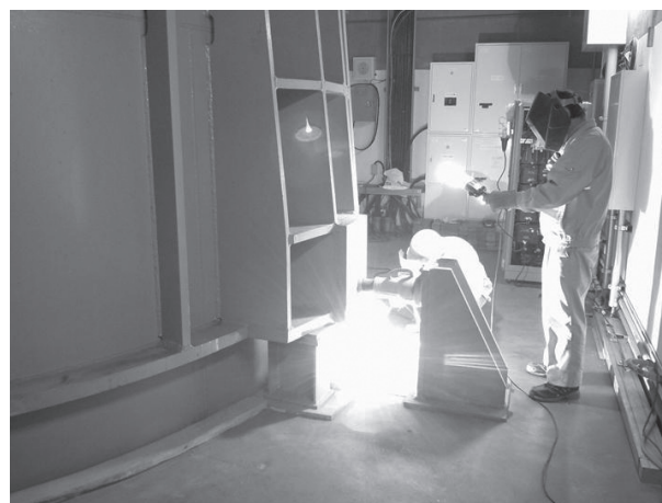
図 19 加速器棟 4 階の加速器本体支持台の溶接固定作業.
