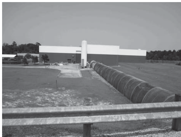
図4 レーザー干渉計の設置された建物 @ Livingston LIGO.
