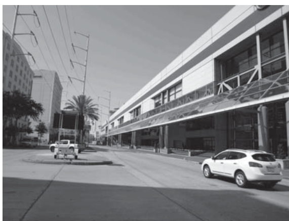
図1 横に長い線の入った右側の建物が Morial Convention Center, New Orleans, USA. ちなみに写真で見えているのが IPAC'12 会場側で、建物の半分の長さにも満たない(折り返して逆側はもっと長い)。
