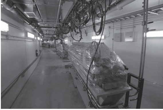
写真1 NSLS-IIの光源リング内に並べられ始めた電磁石
