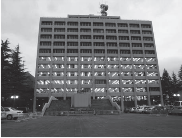
図1 福島県庁 上部階は立ち入り禁止となっており使われていない(5月当時)
