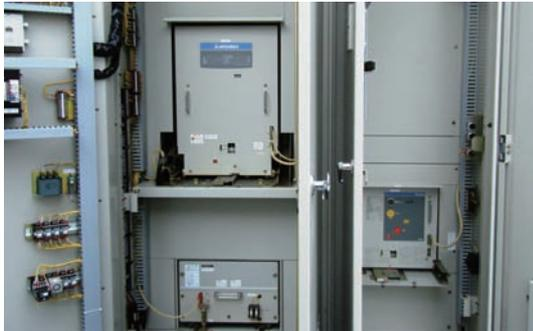
**図2** Super speed switchgear (図中左が超高速遮断器, 右が普通のVCB)。
