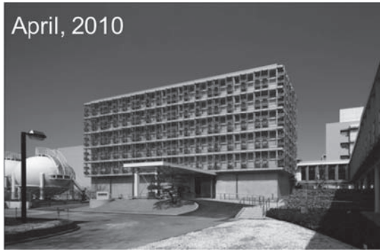
(a) 新治療研究棟の外観
