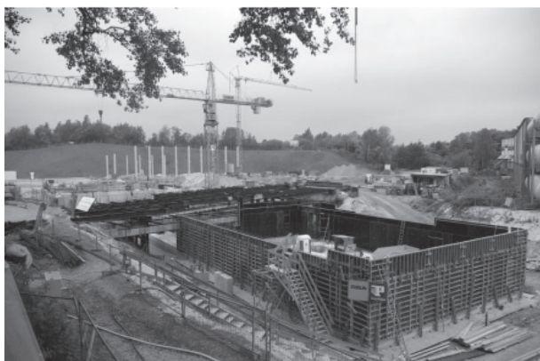
図4 European-XFEL 実験ホールの建設現場
