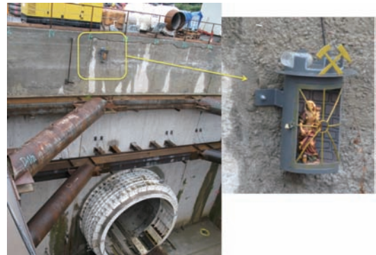
図7 XFEL トンネル掘削現場。壁にあるのは聖バルバラ (Saint Barbara) の像。探鉱、建築、鍛冶、砲兵、地質関連の守護 (女) 神と言われている
