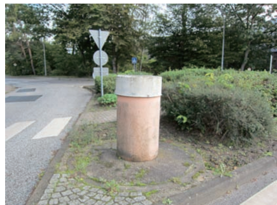
図8 DESY サイトの地上測量用観測ピラー
