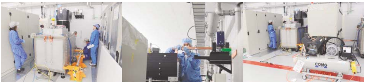
2009年11月19日，クライストロン1台目，導波管を接続。エアパッドはうまく稼動した。
