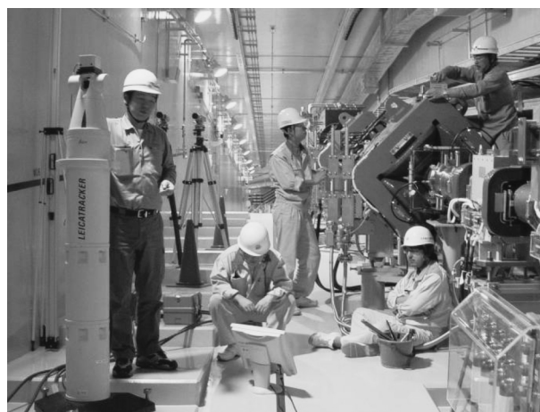
図5 3NBTビームラインとレーザートラッカーを用いたアライメント
