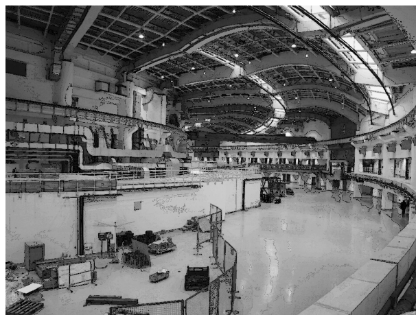
図6 実験フロアと蓄積リングトンネル. 天井はとても高く、渦巻き上に窓が並んでいる
