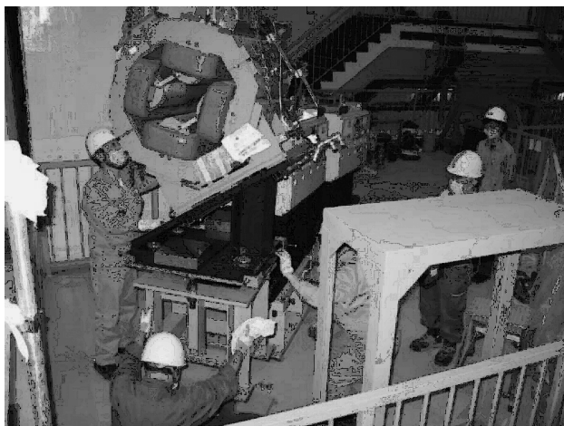
図15 Q3 電磁石据付け
