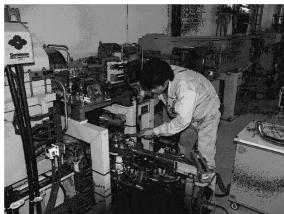
図4 保守点検 (蓄積リング収納部)
