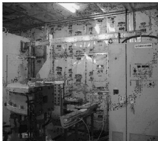
図4 完成なった先進小型シンクロトロンの200 kA 偏向電磁石パルス電源と磁場測定準備中の偏向電磁石
