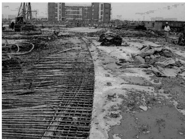
図1 右半分に円周状にコンクリートが打ってあることが分かる。ここが蓄積リングのトンネル基礎部分
