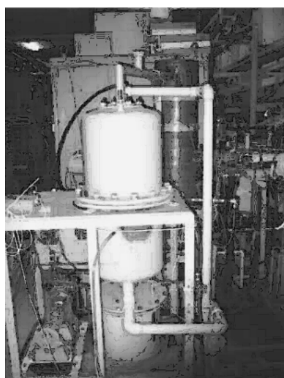
図8 新旧のクライストロンコレクタ冷却装置。左図は旧型の側面で熱交換器下側にFRP樹脂を貼り付けた修理跡が見える。
