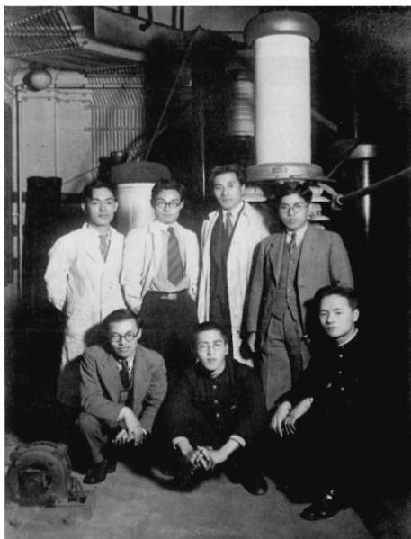
図1 コッククロフト加速器.
