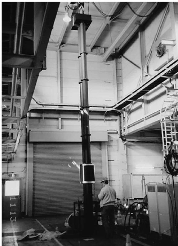
写真2 12 m の光転送縦ダクトを設置している Flanagan さん。
