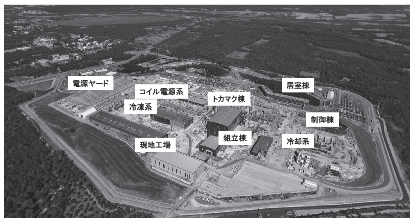
図 15 建設サイトでの建設状況
