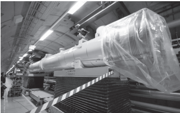
図7 トンネル内へのクライオモジュールの吊り下げの様子。モジュールを移動し吊り下げるための専用の台車(Mullewupp)を用意し、トンネル内に吊り下げる。
