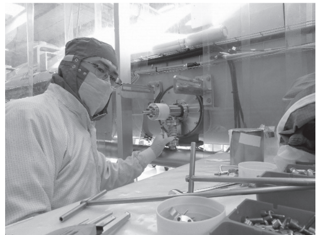
図 13 モジュールの入力カプラーの warm 窓の交換作業の様子. 交換作業中の筆者.
