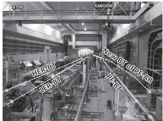
図3 LINAC 第 3 スイッチヤードをビーム下流から上流を見た様子.
