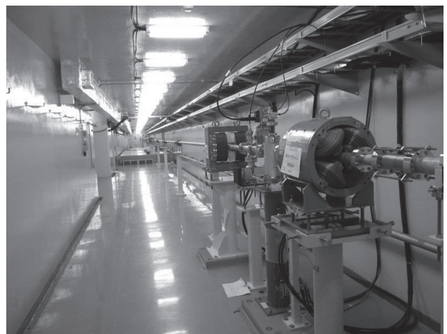
図6 PF-AR新トンネル上流部をビーム下流から上流を眺めた様子。奥に見える段差の下にはSuperKEKBのリングトンネルがある。
