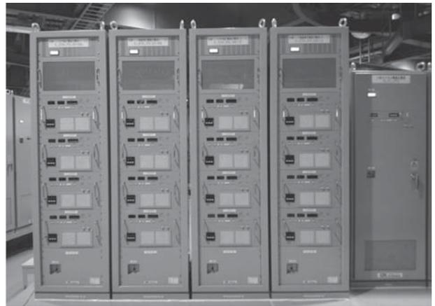
Aichi SR (Aichi Synchrotron Radiation Center) に納入した光源リング系用両極性補正電磁石電源
