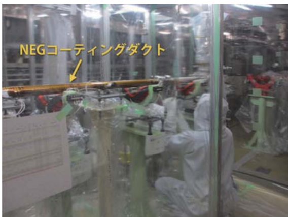
図7 超伝導空洞周辺部の真空機器設置作業
