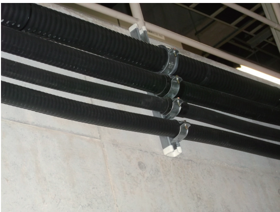
図3 RIBFにおけるコルゲートケーブルの一般的な施工例
