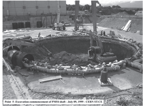
図6 CMS 実験用の立坑の工事では地下水流が速すぎるので液体窒素で壁を凍結して工事を行った。
