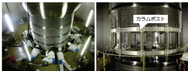
図4：カラムポストの交換作業
