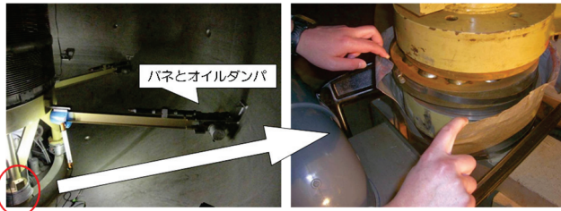
図3：タンデム加速器の免震機構。絶縁カラムはベアリングの上に設置されバネとオイルダンパーを備えた横からの支柱で揺れを抑える。右写真は地震により中心からずれたベアリングである。
