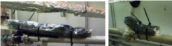
Fig.5 追加遮蔽は、遮蔽パテ（右）を2箇所と鉛毛を（左）1箇所を設置。この時点で遮蔽できたのはビームパイプのごく一部である。遮蔽はプロファイルモニター(M3)と放射線モニター(IM1)を結ぶ直線からは外れている（上図）。
