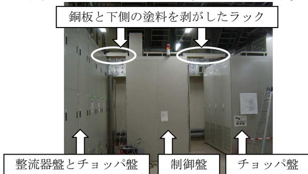
写真1: 水平シフトポンプ電源の外観図
