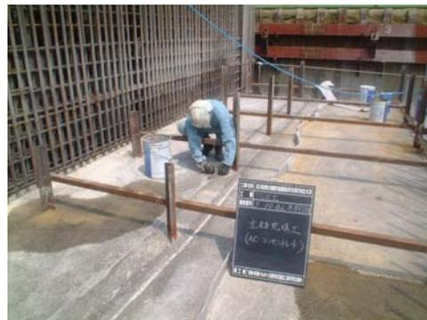
写真6 水平施工打継ぎ面の止水対策
