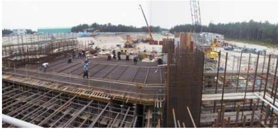
写真3 頂版鉄筋組立状況 (9ブロック)
