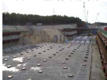
写真2 均しコンクリート打設完了
