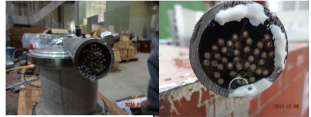
やはり管とエポキシの間で空気が漏れる。管とエポキシの間の隙間をシリコンを塗って気密試験を行うと、圧力を保持する。
