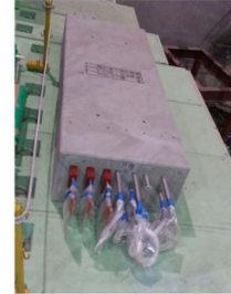
コンクリート打設後(P6)
