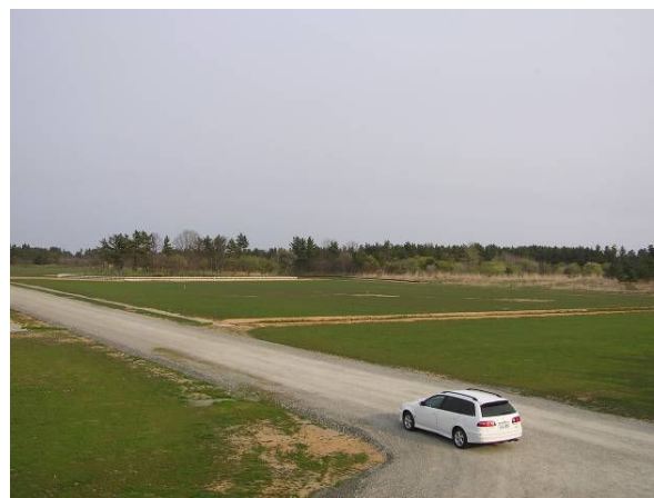
図6 着工直後の状況 (2008. 4. 23)
