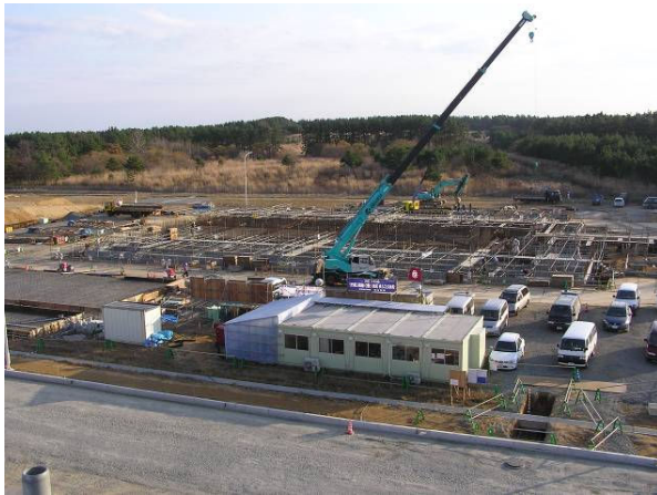
図7 地下躯体工事状況 (2008.11.14)
