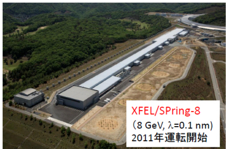
図1 XFEL/SPring-8 線型加速器棟、アンジュレータ棟が完成
