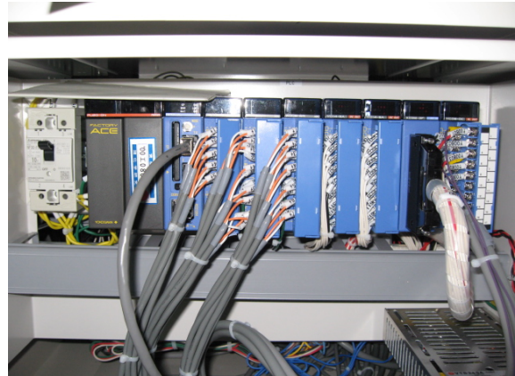
図1：新イオン源制御のF3RP61-2Lシステム
