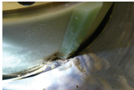
図4 空洞7号機の座屈の様子。座屈部分が内筒の柱の部分と衝突している。
