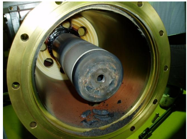
図3： 損傷した同軸管
