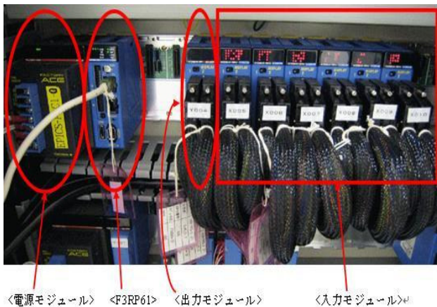
図2：制御システム側のPLC構成
