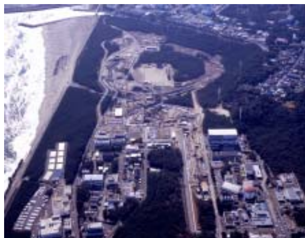
図1: J-PARC加速器施設の建物建設状況。
