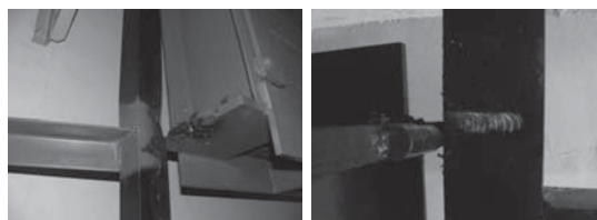
図6 ゴンドラレールの破損と補修作業
