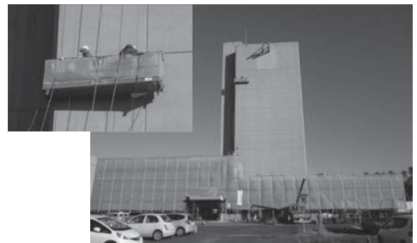
図18 建家外壁の補修。タワー部はゴンドラによる作業となった。
