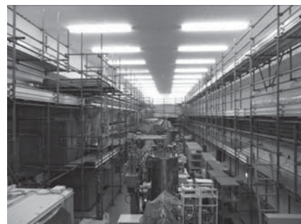
図19 ブースター室内に組んだ補修用足場。
