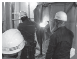
図6 ゴンドラレールの破損と補修作業
