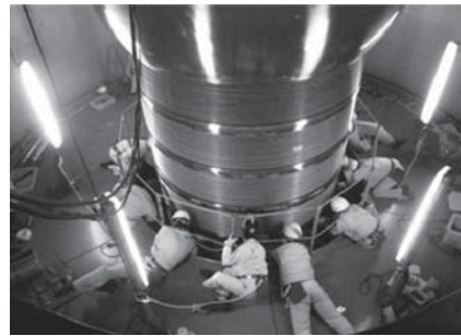
図10 カラムポストの交換作業。写真は交換準備のためのフープ(電界分布をなだらかにする大きなリング)の取り外し作業。
